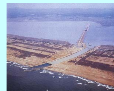
完成した堤防と放水路
