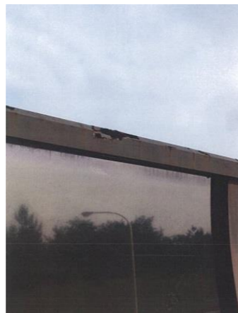
②遊歩道(手すり)
