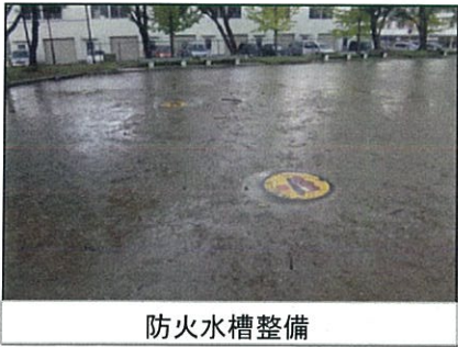
防火水槽整備
