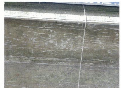
鋼製コルゲート（腐食）健全度 4
