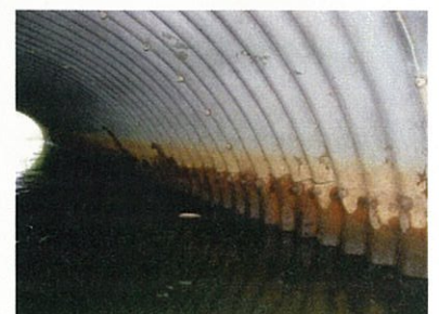
鋼製コルゲート（腐食）健全度 4
