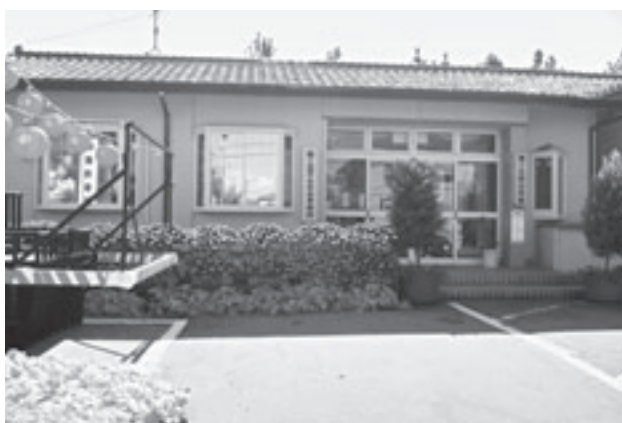
昭和42年建設の鶴ヶ丘西公民館
