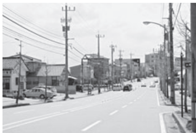
LED照明に交換を開始した医科大通り
