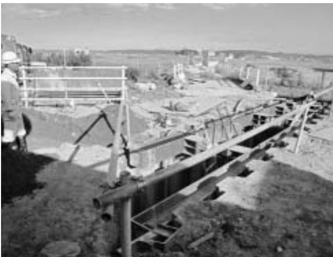
大根布バイパス管を整備する様子 -昨年5月に完成-
