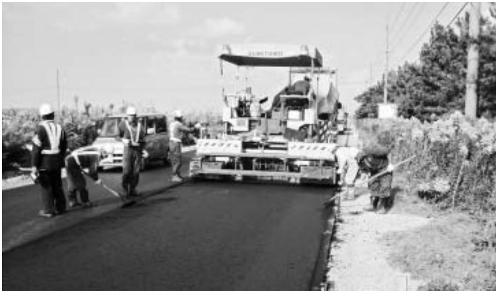
湖西地区の道路舗装工事
