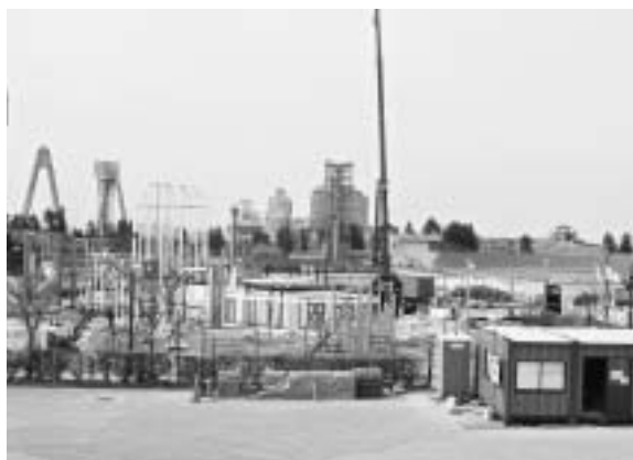
急ピッチで進められる海賊船工事
