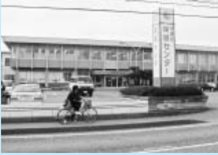
耐震工事される保健センター
