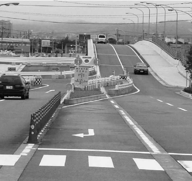
待ち望まれる4車線化(内灘湊大橋)
