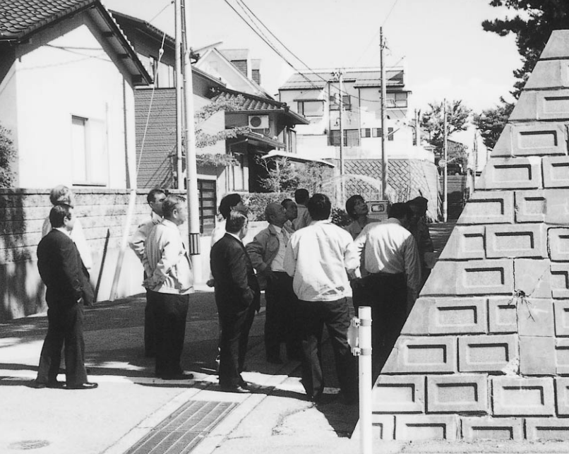
向粟崎小学校擁壁のヒビ割れを視察する議員
