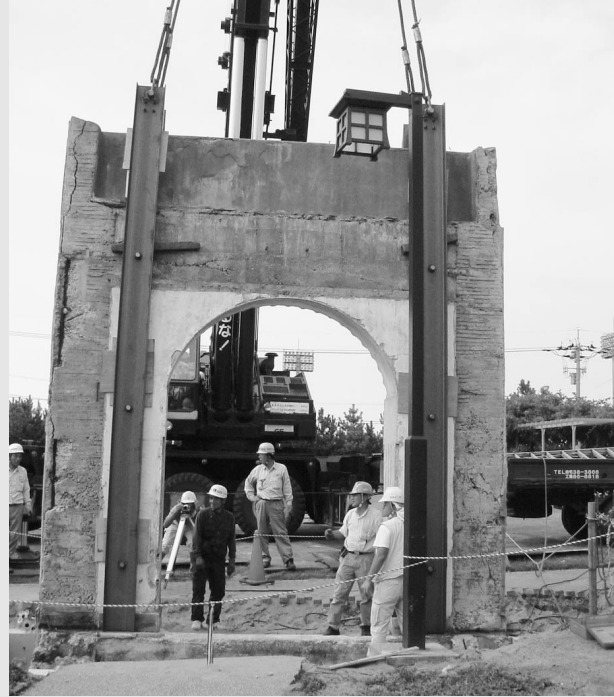
総合公園に設置中の入場門
